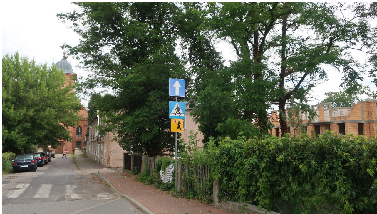
Ryc. 5. Zabudowa wielorodzinna w trakcie budowy w sąsiedztwie zboru
