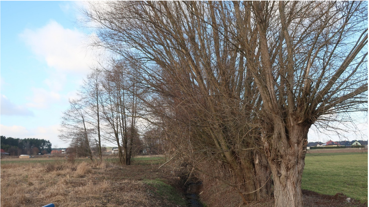
Ryc. 21. Rów Dąbiecki – widok z ul. Nad Zalewem
