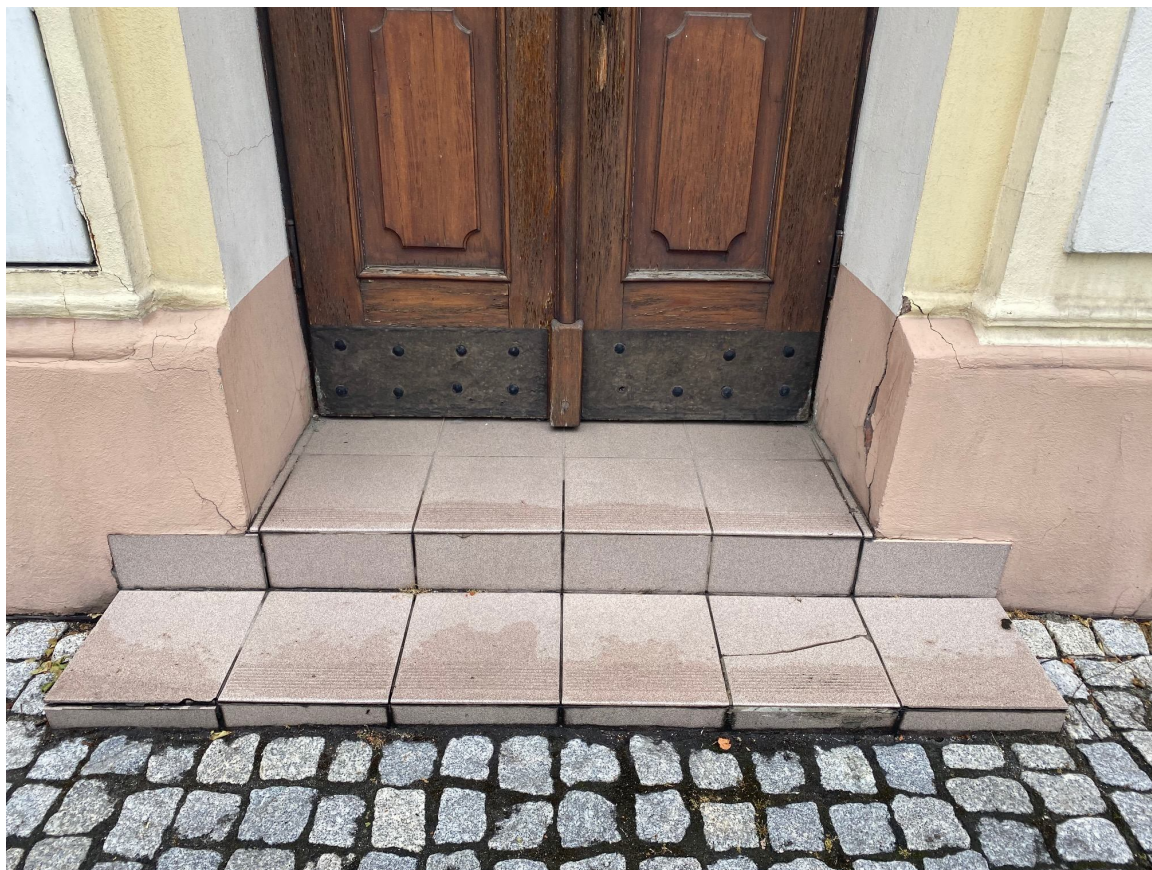
Schody wejściowe do sali widowiskowej
