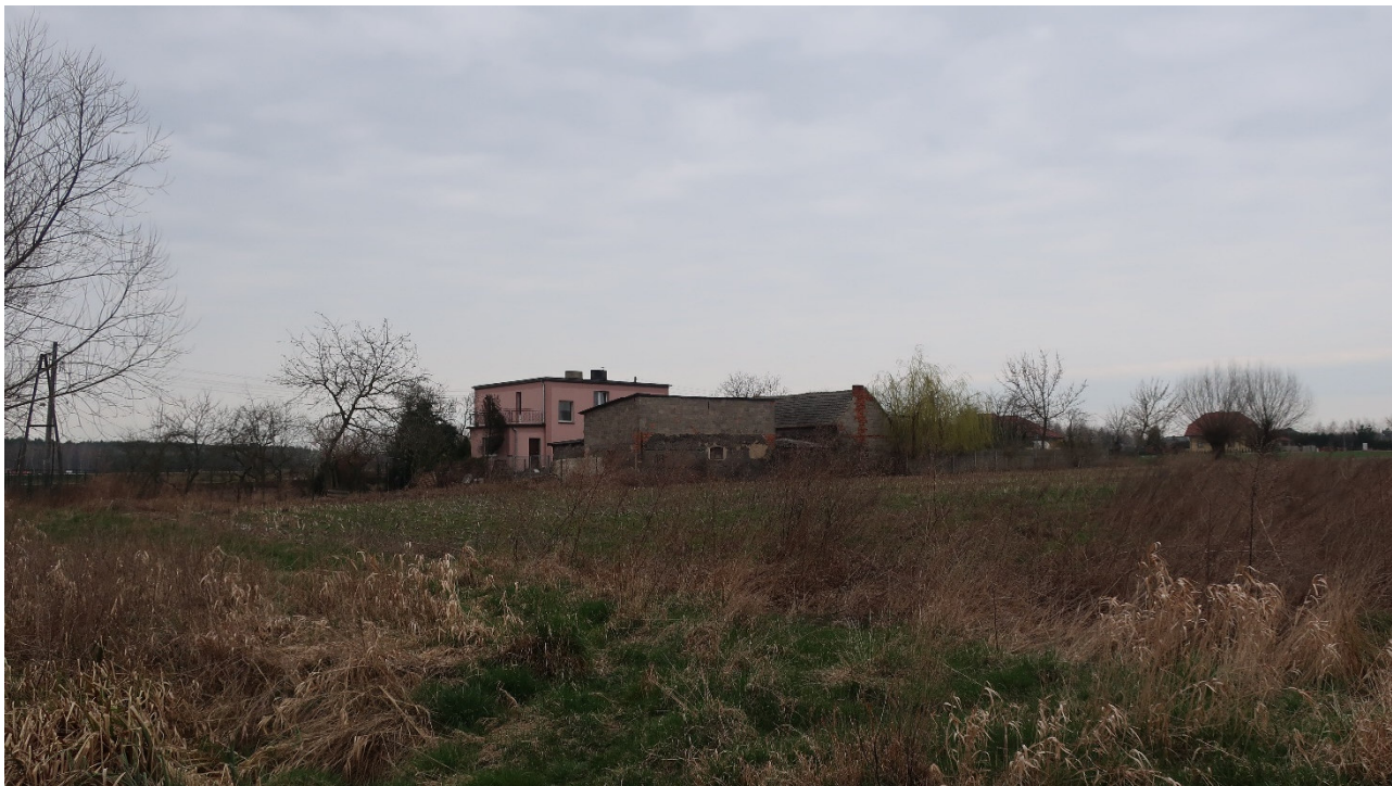
Ryc. 10. Tereny zabudowy zagrodowej przy ul. Rydzyńskiej (przedłużenie ul. S. Wyspiańskiego)
