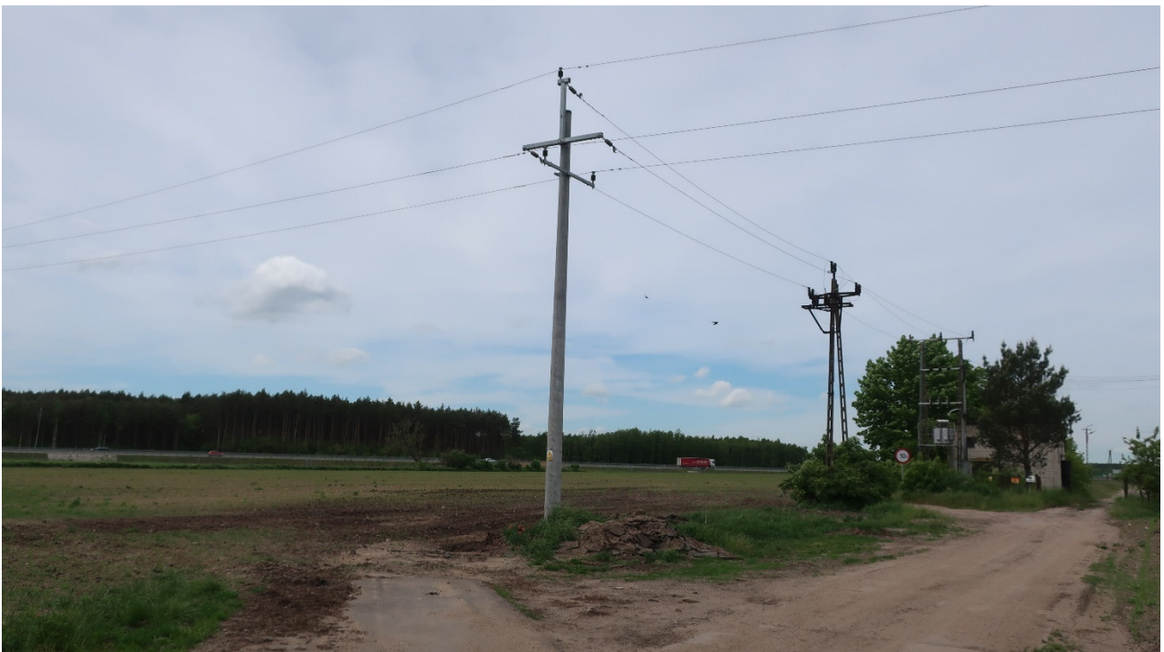
Ryc. 11. Sieci elektroenergetyczne średniego napięcia i sąsiadujący teren drogi ekspresowej
