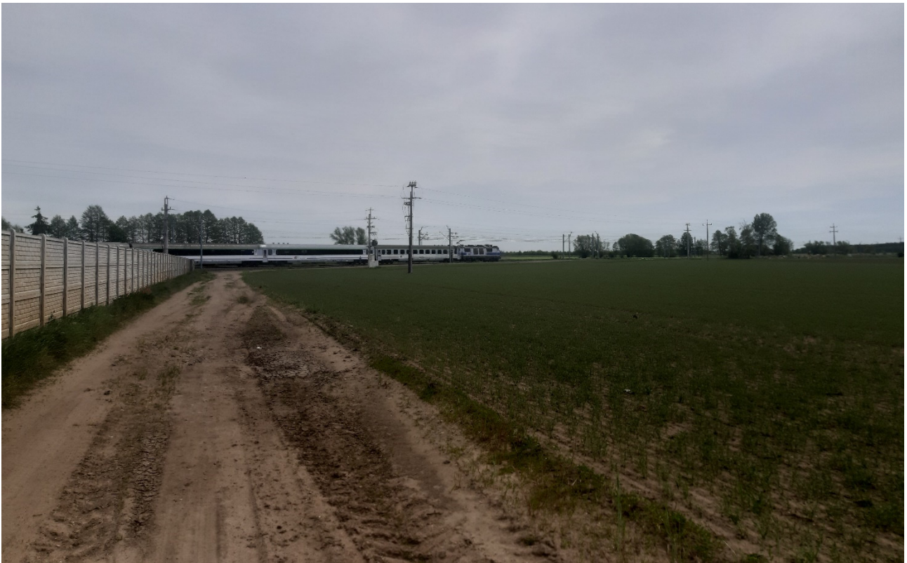
Ryc. 12. Linia kolejowa nr 271 widok z drogi wewnętrznej o nr ewid. 351/3
