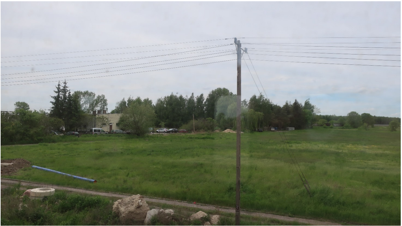
Ryc. 10. Stacja uzdatniania wody – widok z linii kolejowej
